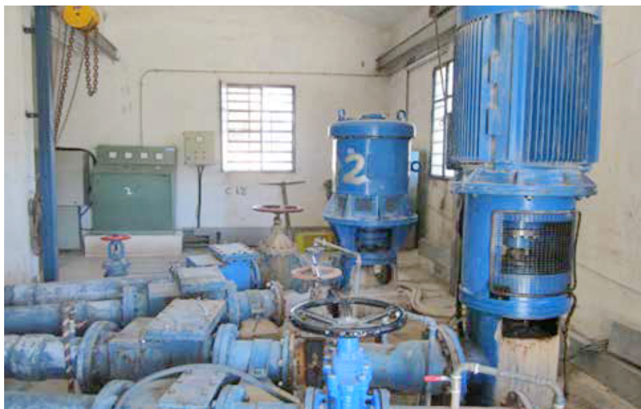
Figura 8. Motores de la Comunidad de Regantes «Virgen del Oro», que elevan aguas del Segura conducidas en la margen derecha por la Acequia Charrara en Abarán (Murcia). Fuente: autores (15-03-2023).
