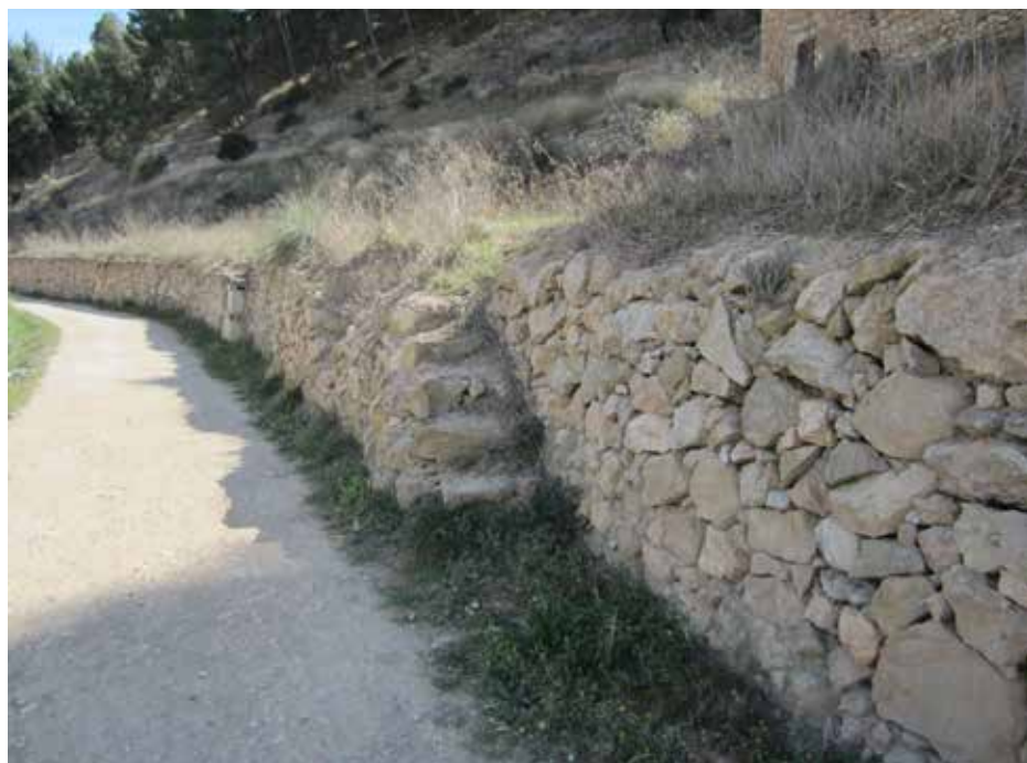
Figura 3. Muros de piedra seca que permiten retener agua y suelo, en la margen derecha del río Segura entre Cieza y Abarán. Fuente: autores (11-02-2023).
