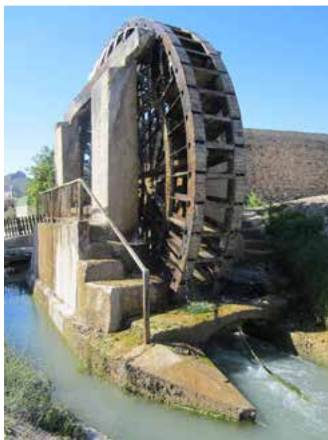
Figura 2. Noria de la Hoya de Don García. Rueda de corriente baja o azuda, de unos 8 metros de diámetro, uno de los símbolos identitarios del Valle de Ricote en la Vega Alta del Segura. Fuente: autores (28-04-2020).
